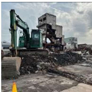
7月の第7陣派遣の時には重機が入っていた。
