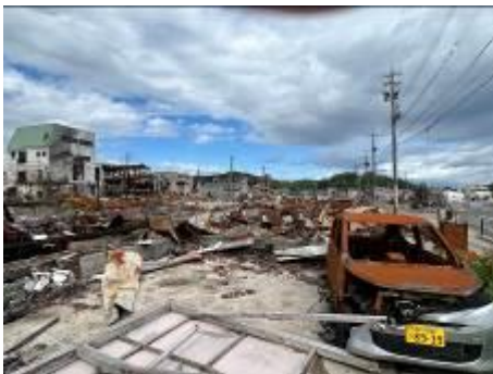
震災から半年経ってもまだ車が片付けられていない状態。
