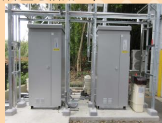
蒸気ボイラー 2 基
