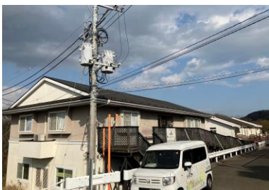
手前からA棟、B棟、C棟で作業ごとに分かれています
