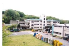
寮棟および工場
